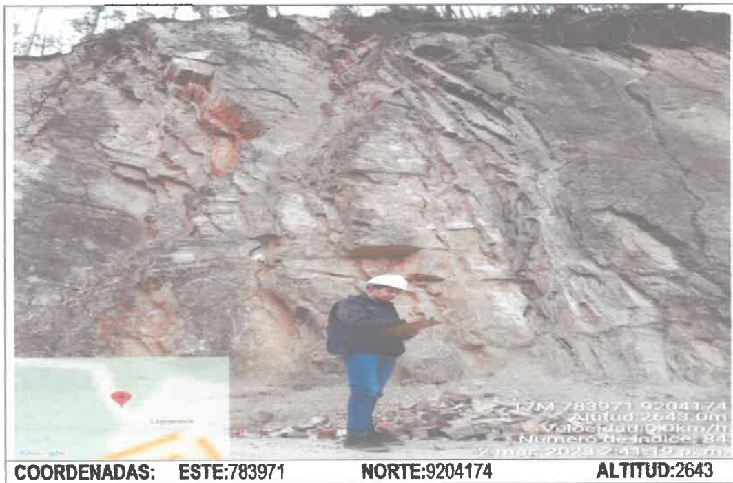
Figura 18: Se observa agrietamientos geológicos y caída de rocas.
