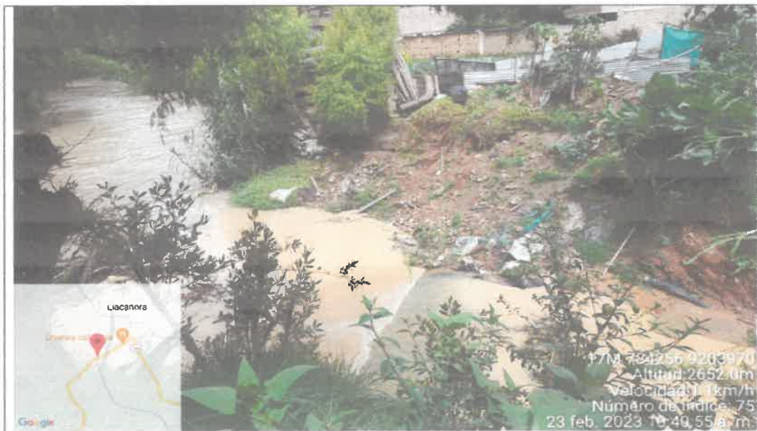
Figura 22: Desembocadura de quebrada Shaullo en el río cajamarquino genera deslizamiento de tierras de las viviendas adyacentes al lecho fluvial.
