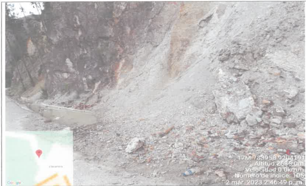
Figura 19: Se observa movimiento de masas (caída de rocas) al borde de la carretera a baños del inca, estas forman escombros que obstaculizan el drenaje en las cunetas.
