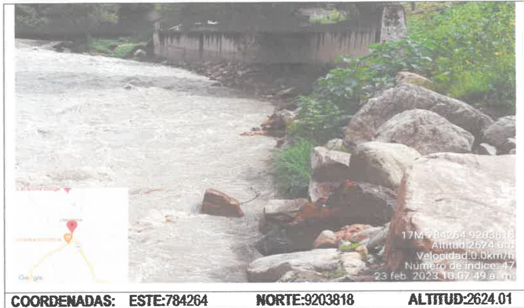
Figura 12: Muro enrocado puesto por los pobladores para evitar que el río salga de su límite ocasionando inundaciones en sus cultivos.
